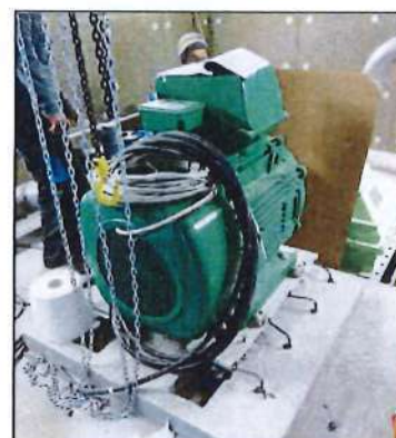
Mise en place de la génératrice >
