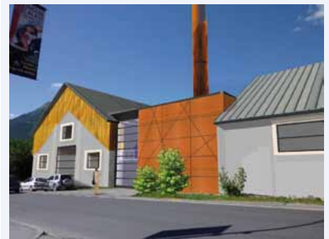
CI-DESSUS : Vue de la chaufferie depuis l'avenue Général Barbot.
