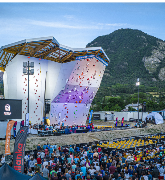
^ Nouveau mur d'escalade ^^ Chantier de la future halle des sports
