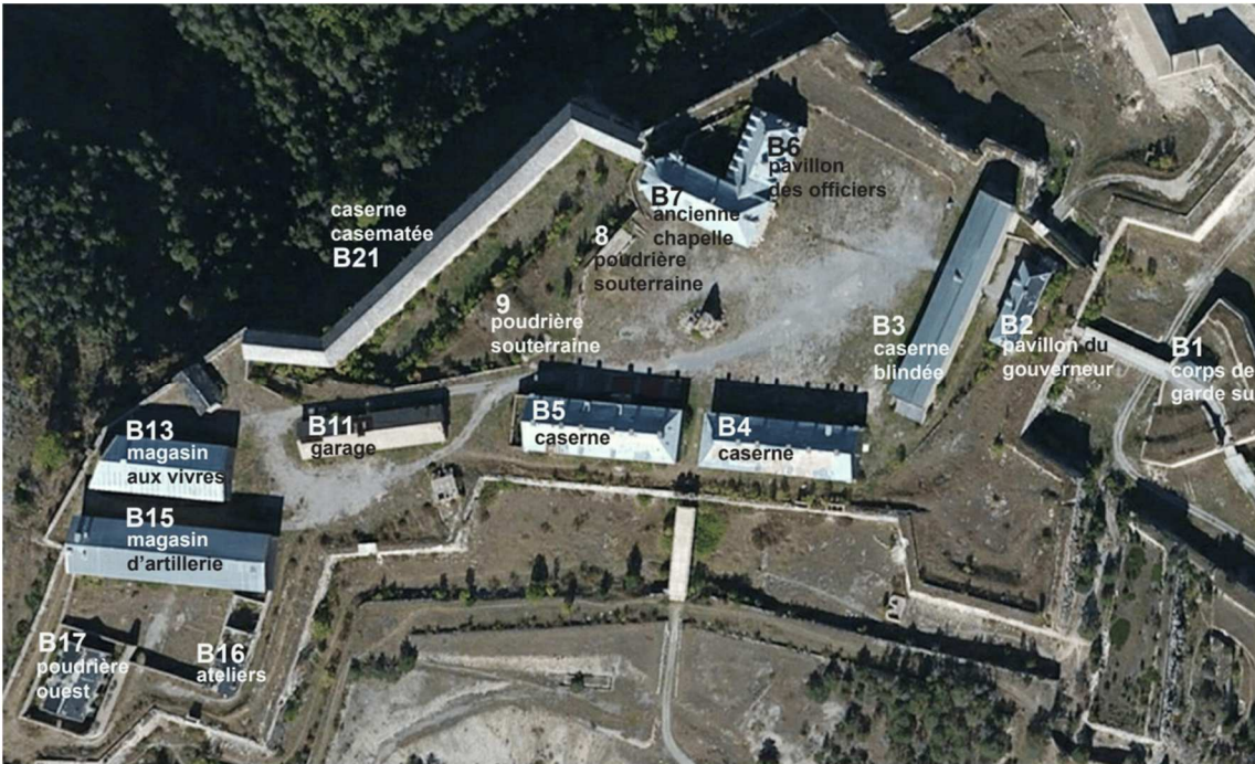
Localisation des bâtiments actuels du site
