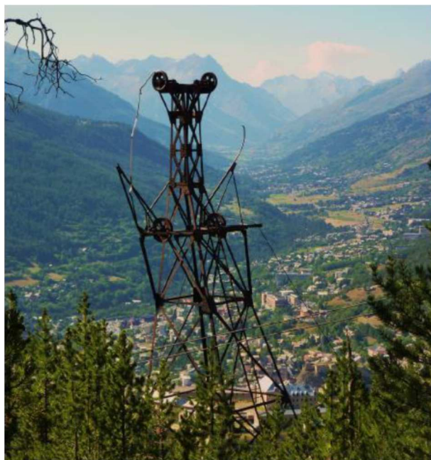
Photographies actuelles du Fort et des pylônes
