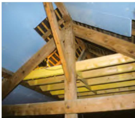
Création de plancher sous toiture Fiche bâtiment – Groupe chiroptère Loire
