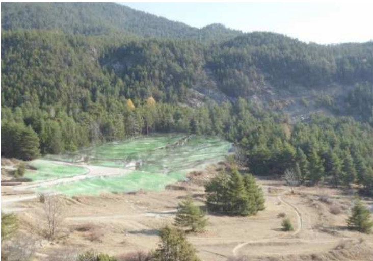
Site après construction du parking
