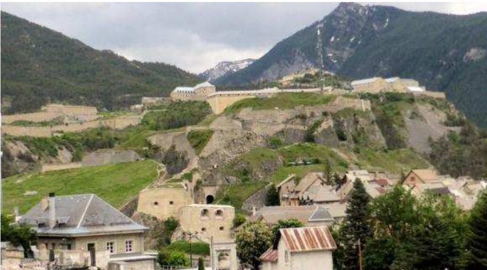
Photo n°2 : vue dominée, depuis le haut de la ville – quartier Colaud
