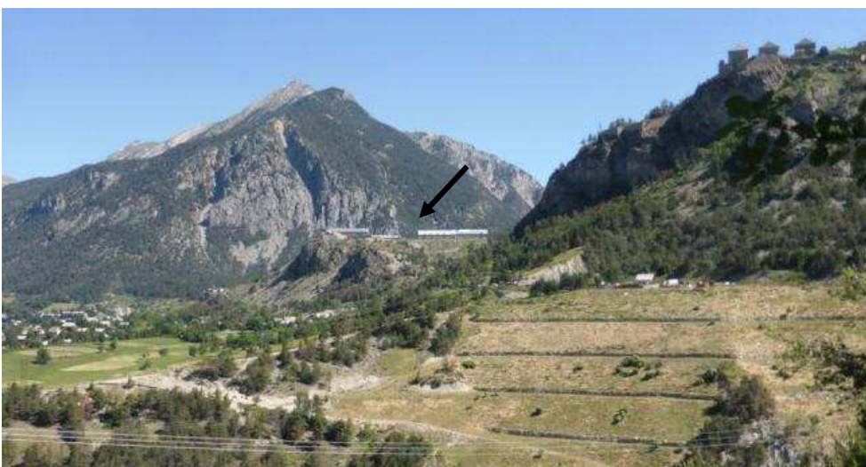
Photo n°6 : vue dominée, depuis la vallée de la Cerveyrette (Villard-Saint-Pancrace)
