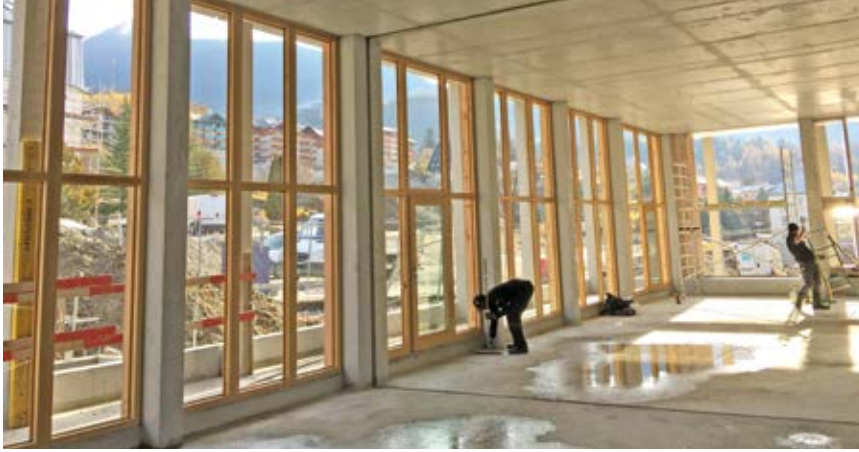
Les travaux ne sont pas finis mais la lumière du Briançonnais entre déjà dans la médiathèque.
