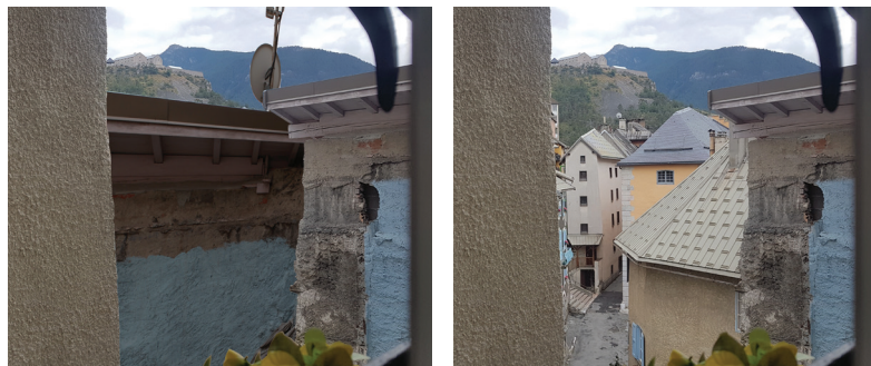
FIG. 3 : Rue du Pont d'Asfeld. Vue depuis l'immeuble adjacent avant et après la démolition. Le vide permet d'ouvrir les vues sur le grand paysage et de diminuer le vis-à-vis.
